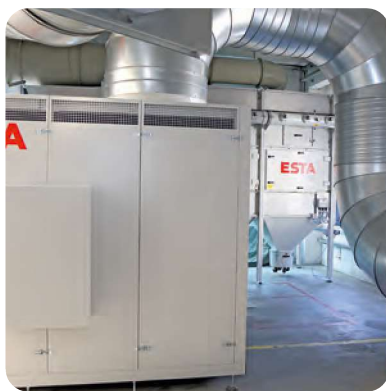
Absaugsystem in separatem Raum
